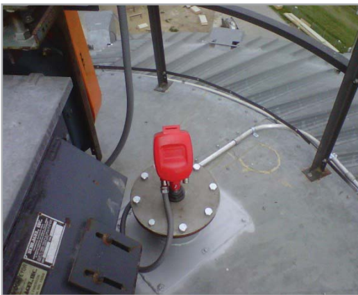
기존 개구부 및 덮개를 사용하여 장착된 스캐너를 보여주는 실제 적용 사례
