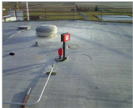
기존 플랜지에 BinMaster 어댑터 플레이트를 사용하여 장착된 실제 적용 사례
